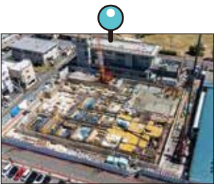
R7.7～9 1・2階躯体工事
