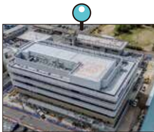
R8.5 外構工事
