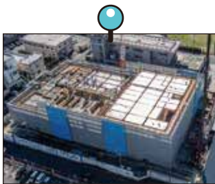
R7.10～R8.4 3～5階躯体工事
