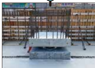
R7.5～6 免震装置据え付け
